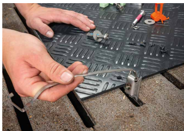
Big Dutchman: Edelstahl-Spaltenanker, fester Sitz, klauenfreundliche Schrauben, aufgrund des Montagebügels leider nur an den Kopfseiten einsetzbar.
