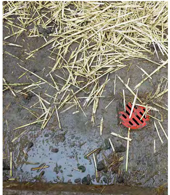
Durch den geschlitzten roten Deckel fließt die Jauche in die Funke JGS®-Rinne.
