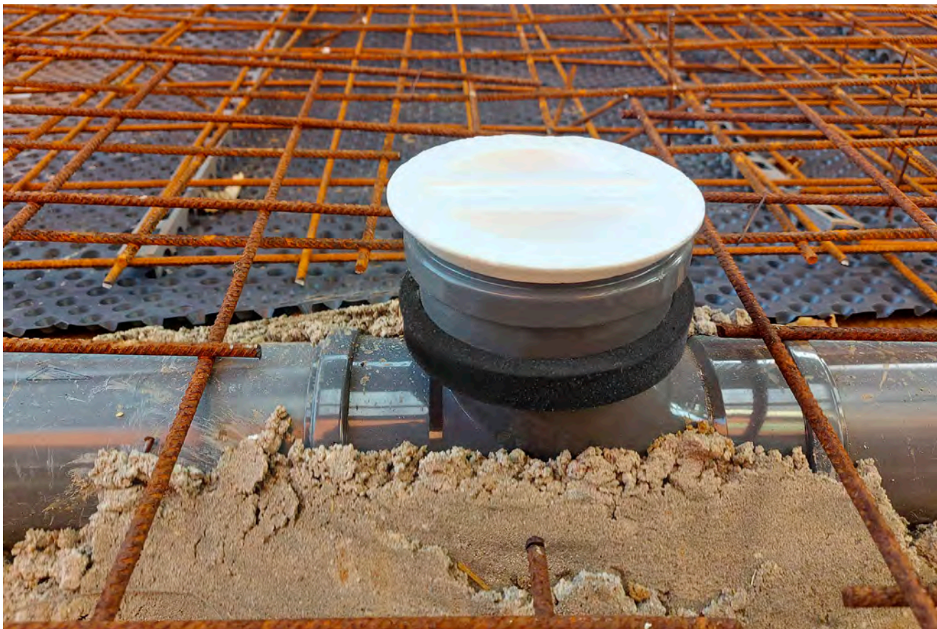
Ein Betonschalstopfen aus Polystyrol schützt die Rinne beim Betonieren vor Verschmutzung und dient als Nivellierpunkt für die Höhe des Betonbodens.
