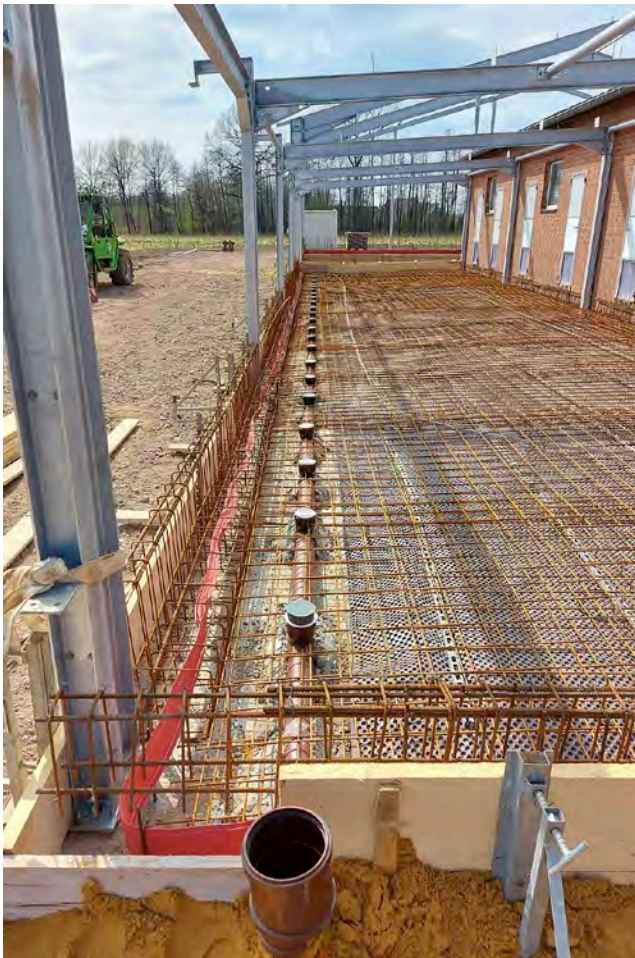
Vorbereitung des neuen Auslaufbereiches für die Betonierung der Sohle.
