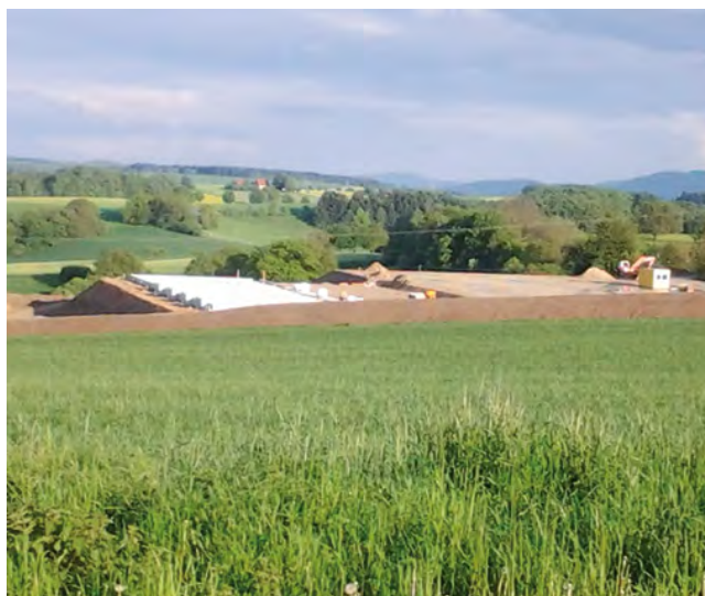
Baufortschritt in Hohensonne: Anfang Mai 2014 – Die Erdarbeiten sind erledigt.
