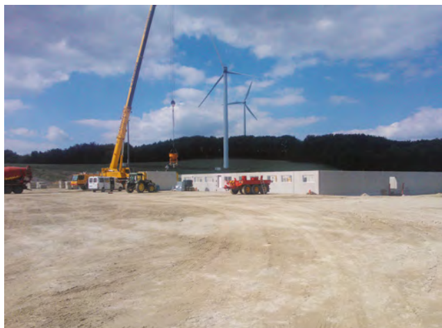
Baufortschritt in Hohensonne: Mitte Juni – Großes Gerät – für die Wände.
