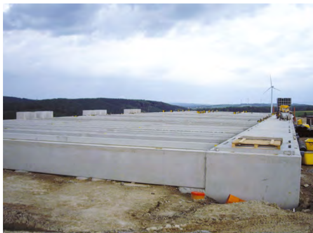
Baufortschritt in Hohensonne: Mitte Mai – Fundamente liegen
