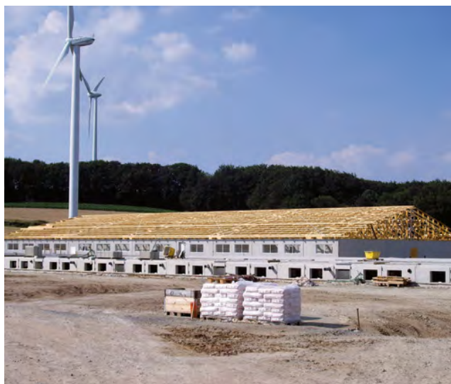
Baufortschritt in Hohensonne: Mitte Juli – Die Dachkonstruktion ist errichtet.
